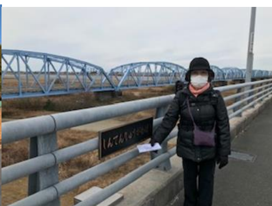
写真2 新天竜橋（広い歩道がある）
